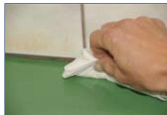
**3** Nach Einwirken von OTTOSEAL® SilOut wird die aufgelöste Siliconmasse mit einer Spachtel und einem feuchten Stofftuch entfernt. Falls erforderlich wird die Behandlung mit OTTOSEAL® SilOut wiederholt. Vor einer Neuverfugung müssen sämtliche Reste von OTTOSEAL® SilOut rückstandslos entfernt werden.
