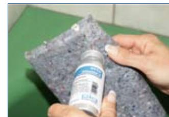
**4** Fugenflanken und Untergrund ausreichend trocknen lassen. Zur Reinigung der Fugen und des Untergrundes eignen sich OTTO Cleaner T oder Brennspritus. Besonders bei schmalen oder tiefen Fugen, oder auch bei rauen Untergründen (z.B. Mauerwerk, Putz, Randdämmstreifen u.ä.) ist darauf zu achten, dass noch vorhandene Rückstände von OTTOSEAL® SilOut unbedingt mit einem feuchten Stofftuch entfernt werden. Reste von OTTOSEAL® SilOut führen bei der Neuverfugung zu einer Schädigung des Dichtstoffes!
