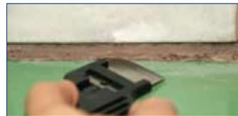
**1** Den Dichtstoff weitestgehend mechanisch entfernen.
