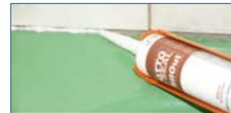
**2** OTTOSEAL® SilOut satt auf die zu behandelnde Fläche auftragen – mindestens 5 mm. Einwirkzeit – je nach Silicondichtstofftype:
